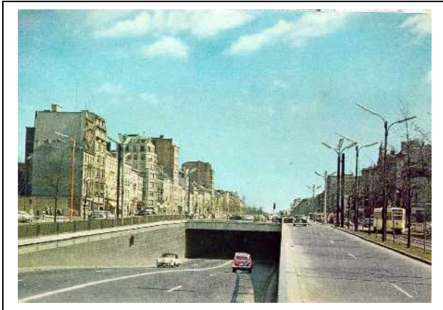
Petite Ceinture tunnel Porte Louise
